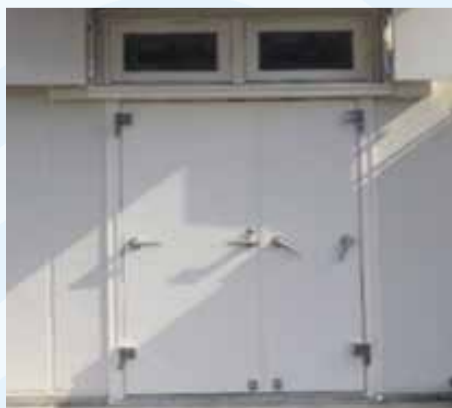
▲止水扉の設置
