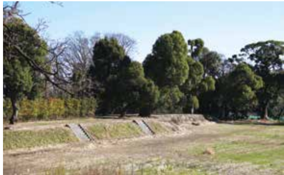
▲開放中の北西土塁から整備工事のようすを見ることができます
