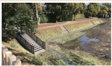
▲整備が完了した北東土塁
