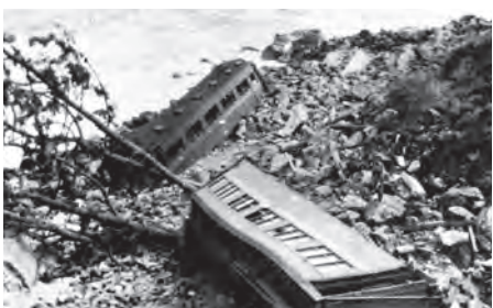
▲土石流により海岸まで押し流された列車
