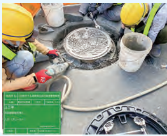
▲マンホール修繕の様子
