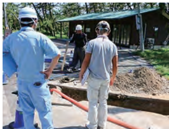
▲現場確認の様子
