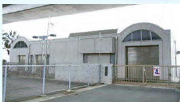
▲早川中継ポンプ場
