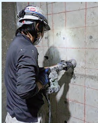
▲早川中継ポンプ場の耐震補強工事の様子
