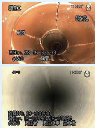
▲管内部の工事前(上)後(下)の状況
