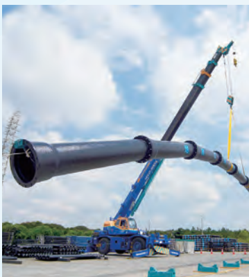
▲水道管(ダクタイル鋳鉄管)耐震継手の検証の様子
