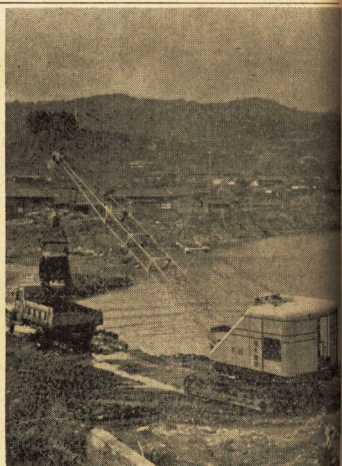
【写真は小田原漁港において パワーシャベルによる 内港掘さく作業】
