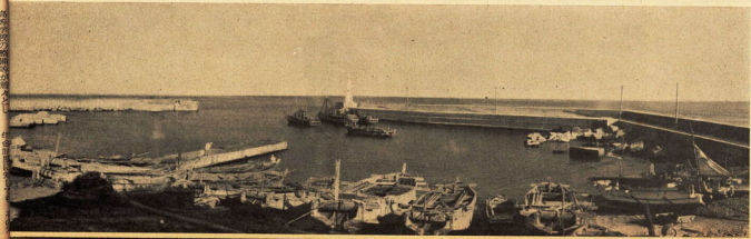
◆小田原漁港修築事業 (前田区) 開港時、昭和二十三年開始、四十七年度工事の進捗 予定防波堤四、八〇〇m、堤防堤二、四〇〇m、灯台 等完成、目片橋等、引揚等々中 橋、管径八、〇〇〇mmの埋設
