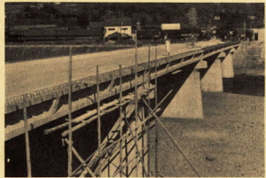
◆大塚橋りょう架設工事
