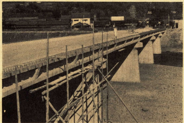
◇大窪橋橋りょう架設工事
