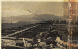
建設中の西湘海岸バイパス酒川橋の架橋工事
