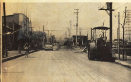
継続施工中の都市計画街路飯泉国府津線
