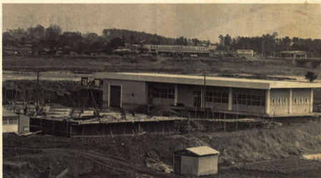
下水道終末処理場 下水道整備事業の一環として昭和39年度から市内今井地区で着工。ことしの中ごろまでには簡易処理が開始される見込み。施設全体の完成目標は昭和46年度。完成後は17万2,000人の汚水処理が可能。総工費は約17億円。
