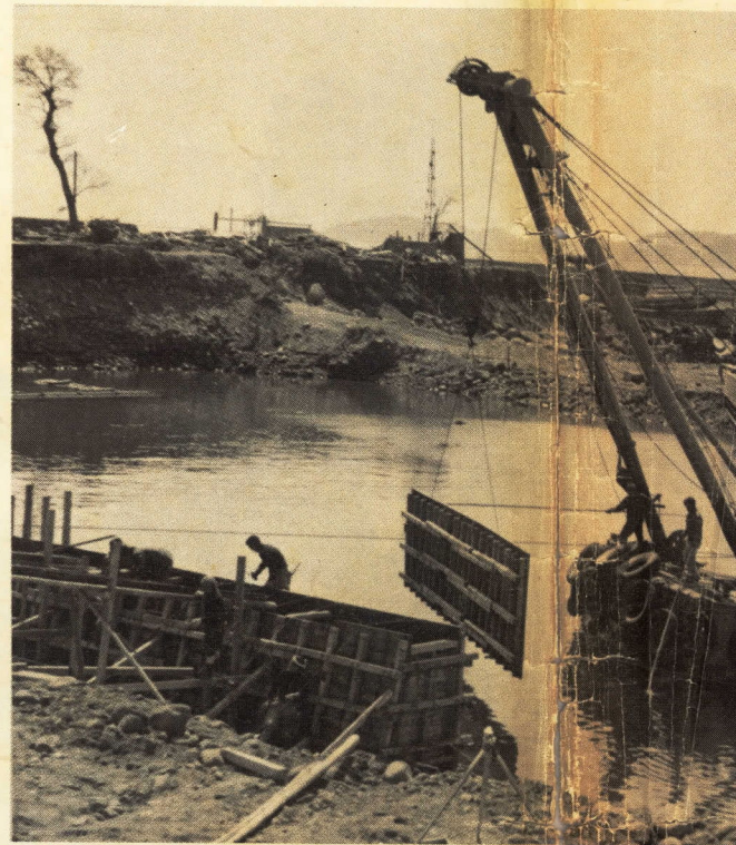
急ピッチで進む小田原漁港の修築事業
