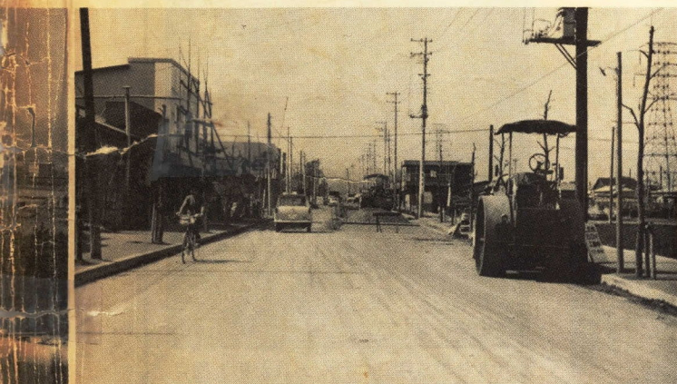
継続施工中の都市計画街路飯泉国府津線
