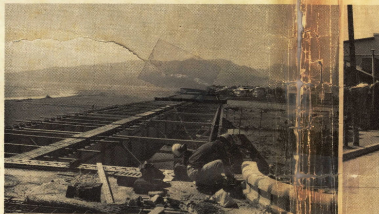
建設中の西湘海岸バイパス酒匂川橋の架橋工事
