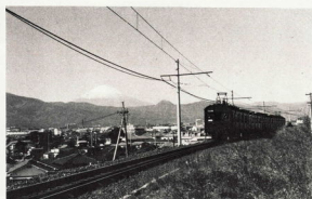
◀電化された御殿場線
