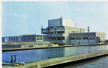
▲44年7月高田浄水場一部完成
