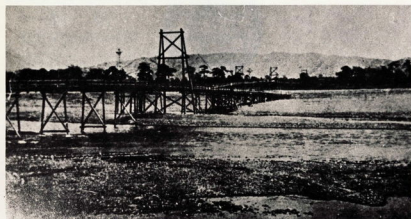
▲大正中頃の飯泉橋
