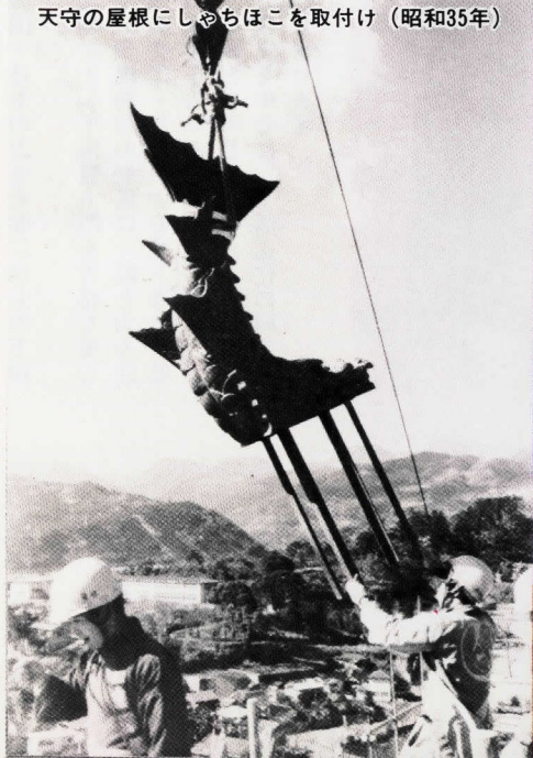
天守の屋根にしやちほこを取付け(昭和35年)
