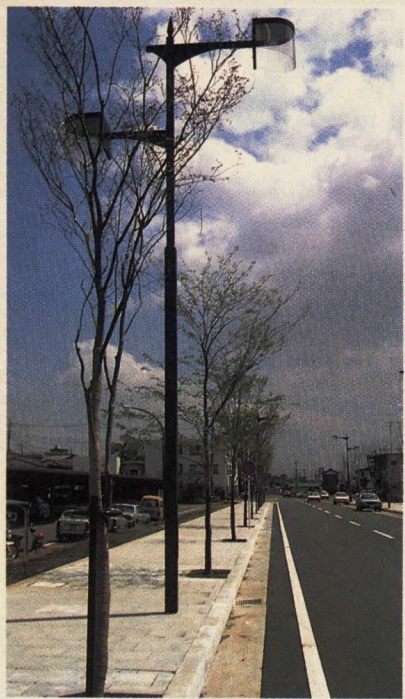
整備が進む都市計画道路 扇町萩窪線
