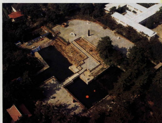
史跡の調査・整備 (国指定史跡) 小田原城跡
