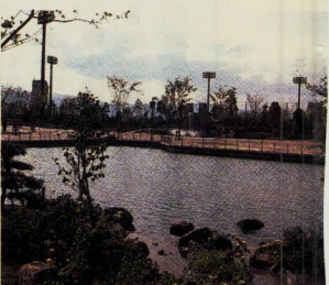
整備が進む上府中公園
