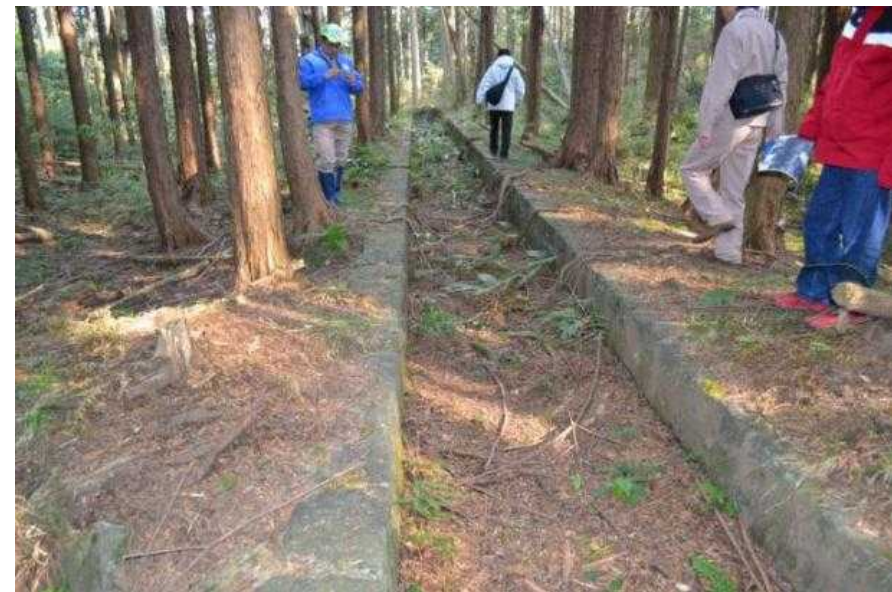
小水力発電所遺構
