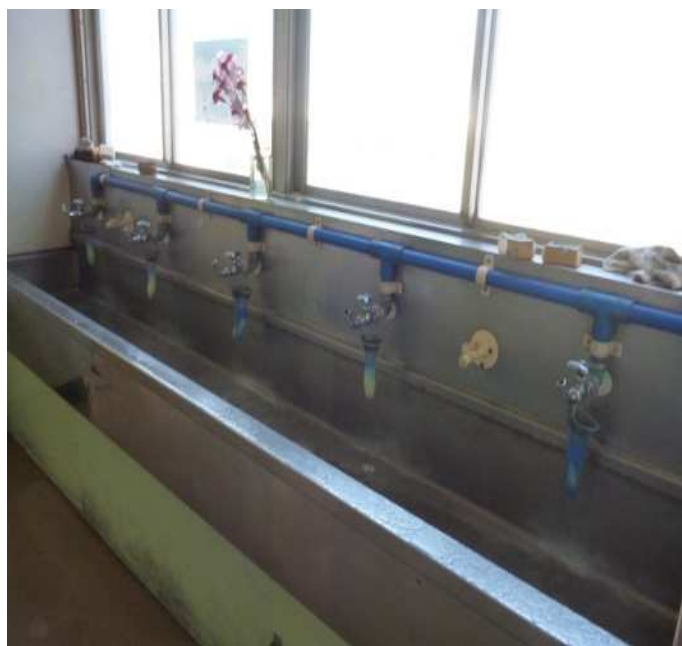
上向きにされた蛇口（4階水飲み場） 発見時放水状態
