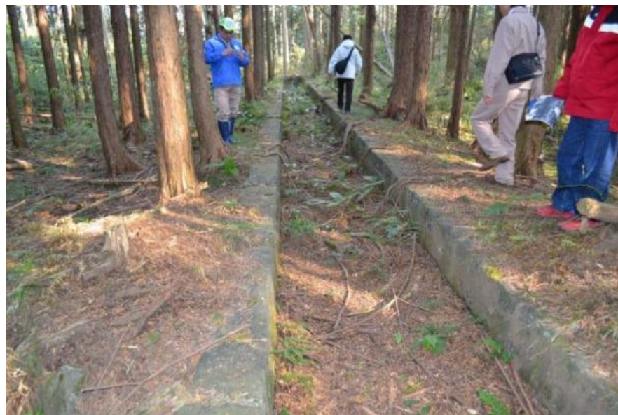
小水力発電所遺構
