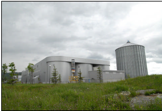
写真5 バイオガス化施設 全景 (中空知衛生施設組合)
