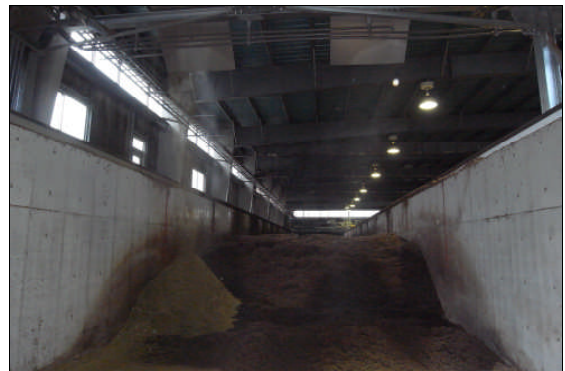
写真3 堆肥化プラント(町田市)
