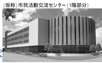
(仮称)市民活動交流センター(1階部分)
