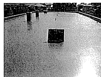
《防水工事施工後》
