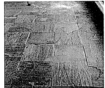
《床の剥がれ・傷み》
