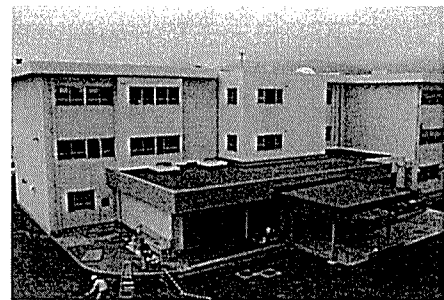
《外壁改修後の白山中》
