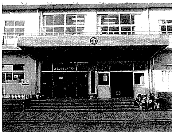
《外壁改修・城山中学校》
