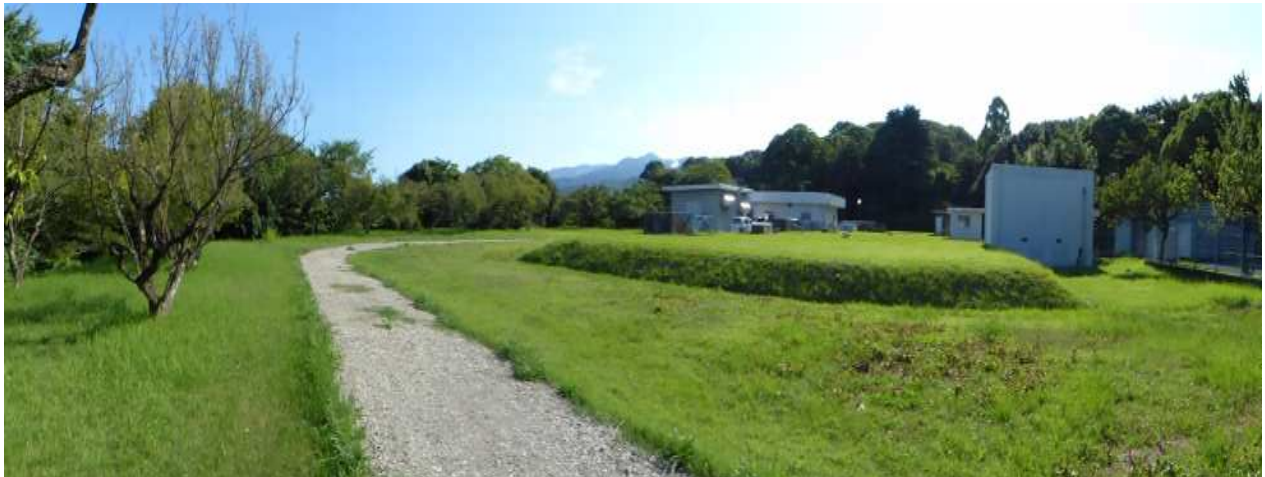
五つの配水池は地下に埋設
