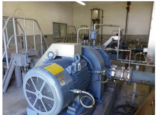
このポンプで高台の新久野配水池に送水
