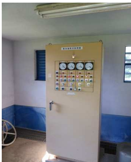
大地震等の緊急時に対応する 緊急遮断弁の制御装置
