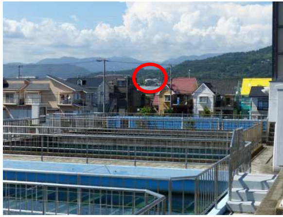
高田浄水場から中河原配水池を望む
