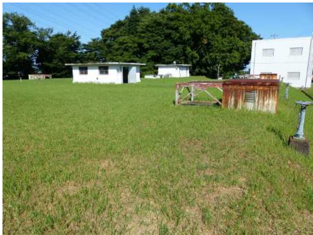
四つの配水池は芝生の下に埋設
