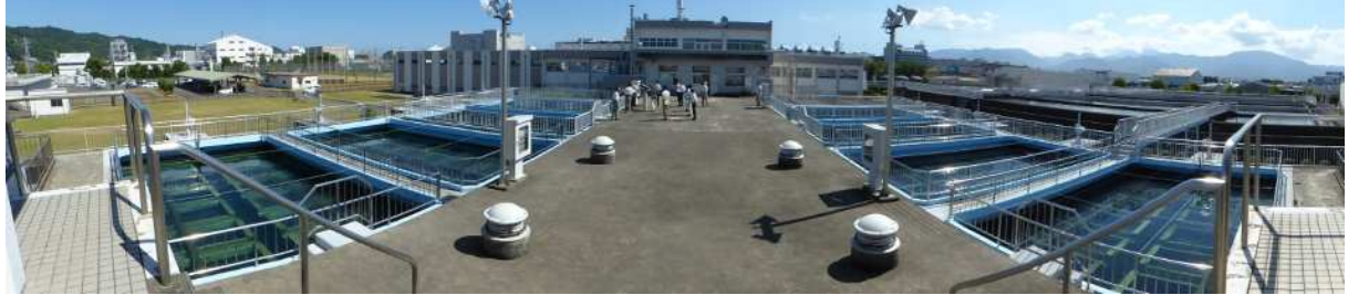
着水井 フロック形成池 沈でん池 急速ろ過池 浄水池（地中）の順に処理が進む （写真は左右に急速ろ過池を挟んだ場所での説明の様子）
