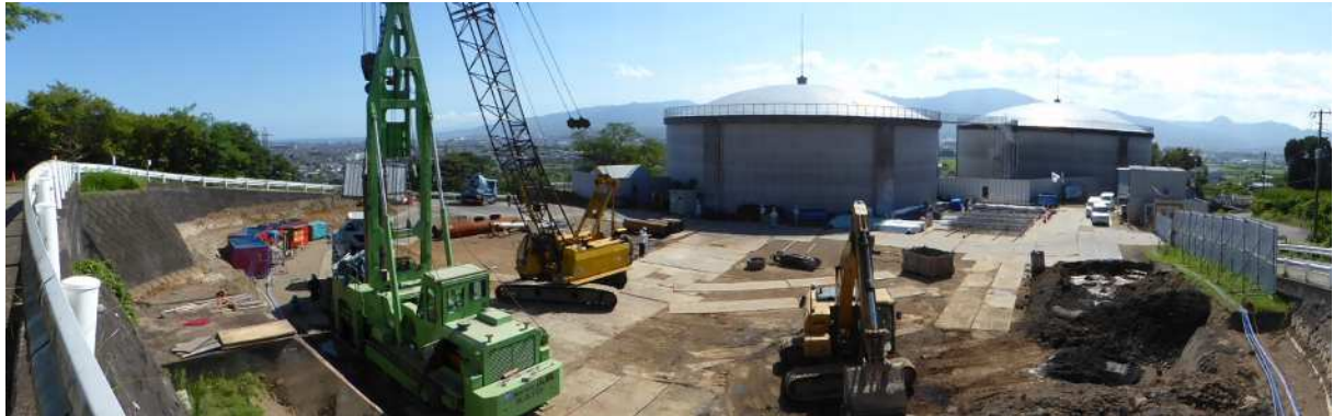
3号配水池の築造（事業費：約9.2億円）が進む中河原配水池（右奥から1号配水池、2号配水池）
