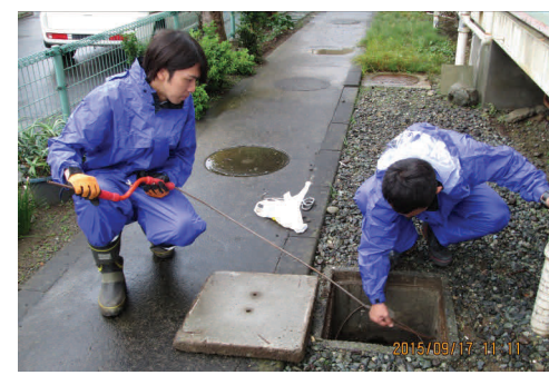
雨水の排水管に詰まった泥の清掃
