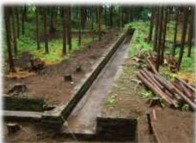
小水力発電所跡（沈砂池）
