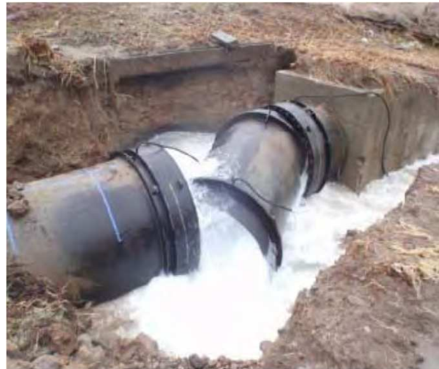
送水管の離脱による漏水
