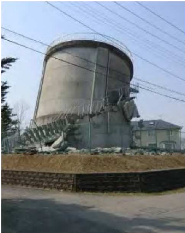
配水池タンクの倒壊
