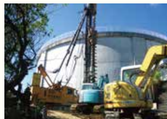
配水池の耐震補強
