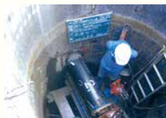
汚水管の整備
