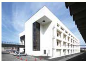
生涯学習センターけやきの耐震工事
