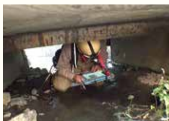
道路・橋りょうの管理
