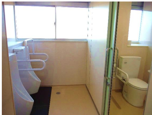
改修後のトイレ
