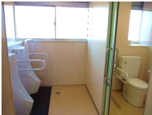
改修後のトイレ
