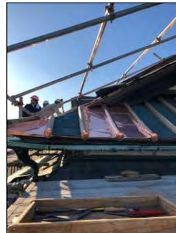
屋根材(銅板葺き) 改修作業中
