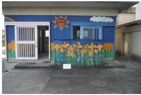
報徳小学校 運動場トイレ目隠し壁
