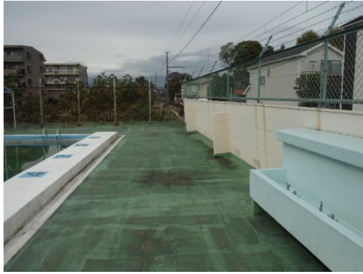
芦子小学校 線路境界（プール側）
