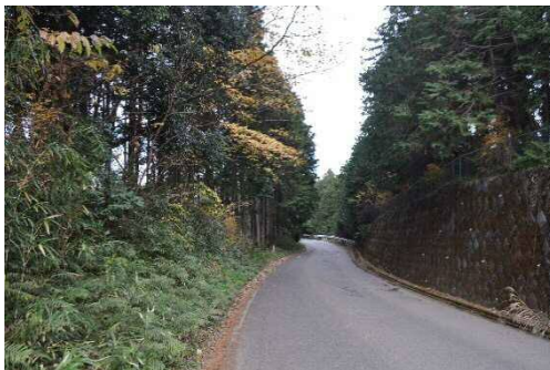
道路で分断された区域
