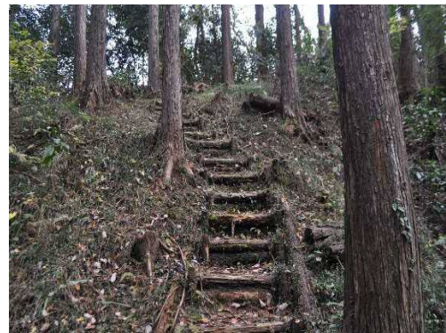
急勾配区間に整備された木階段
