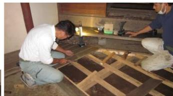
実習作業②(腐朽した根太を修復し羽目板を原状復帰)
