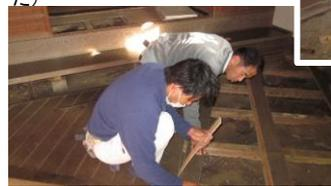
実習作業①(羽目板を外し土台部分を確認)
