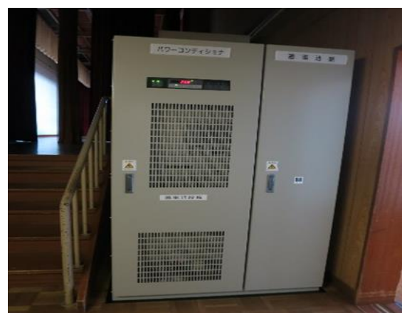
↑ 片浦小学校に設置された太陽光発電設備(10.94kW)と蓄電池(12.65kWh)
