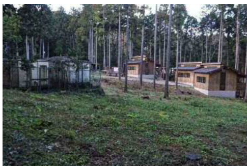
バンガロー建設予定地
