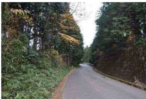
道路で分断された区域
