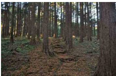
傷んだ木製階段
