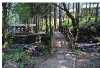
E2 きつつき橋
