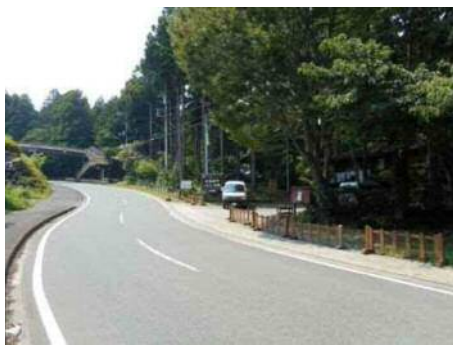
外観（管理棟前）
