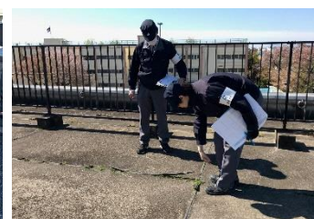
屋上防水調査
