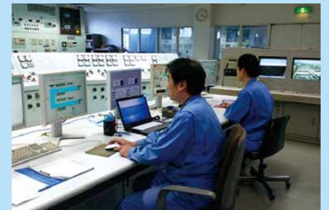
中央監視室の運転状況
