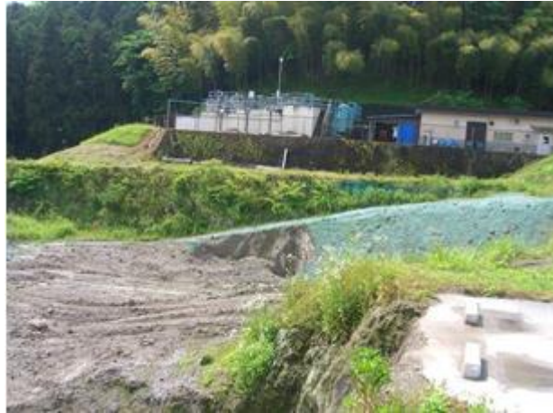
堀ヶ窪埋立処分場
