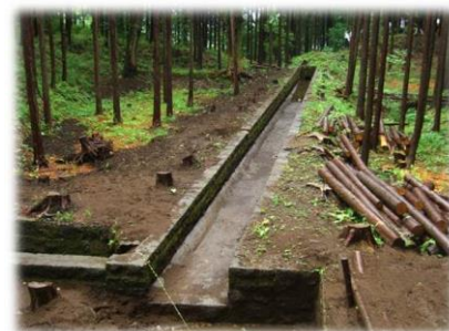
小水力発電所跡（沈砂池）
