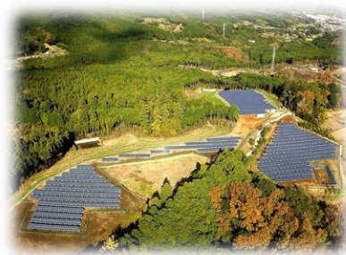
市内のメガソーラー発電所
