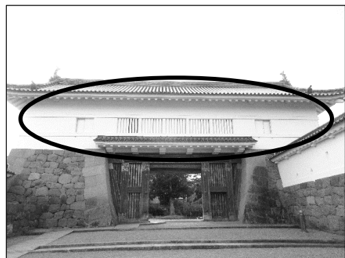
主な修復箇所
