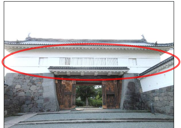
主な修復箇所
