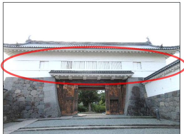
主な修復箇所
