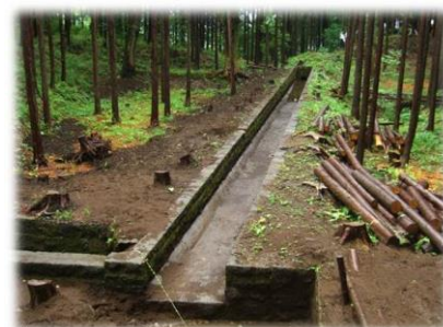
小水力発電所跡（沈砂池）
