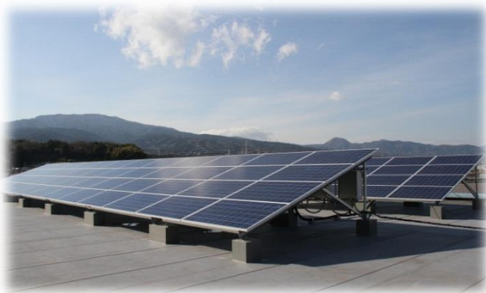
太陽光発電屋根貸し事業において設置された富水小学校
