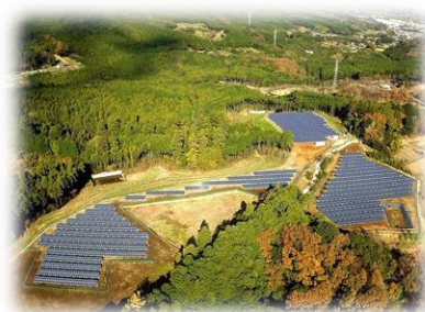
市内のメガソーラー発電所
