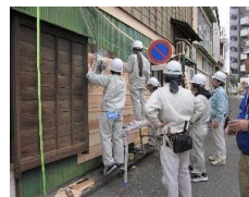
腰壁の木質化修復実習の様子
