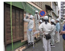
腰壁の木質化修復実習の様子
