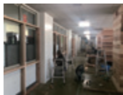
⑦現場工事
