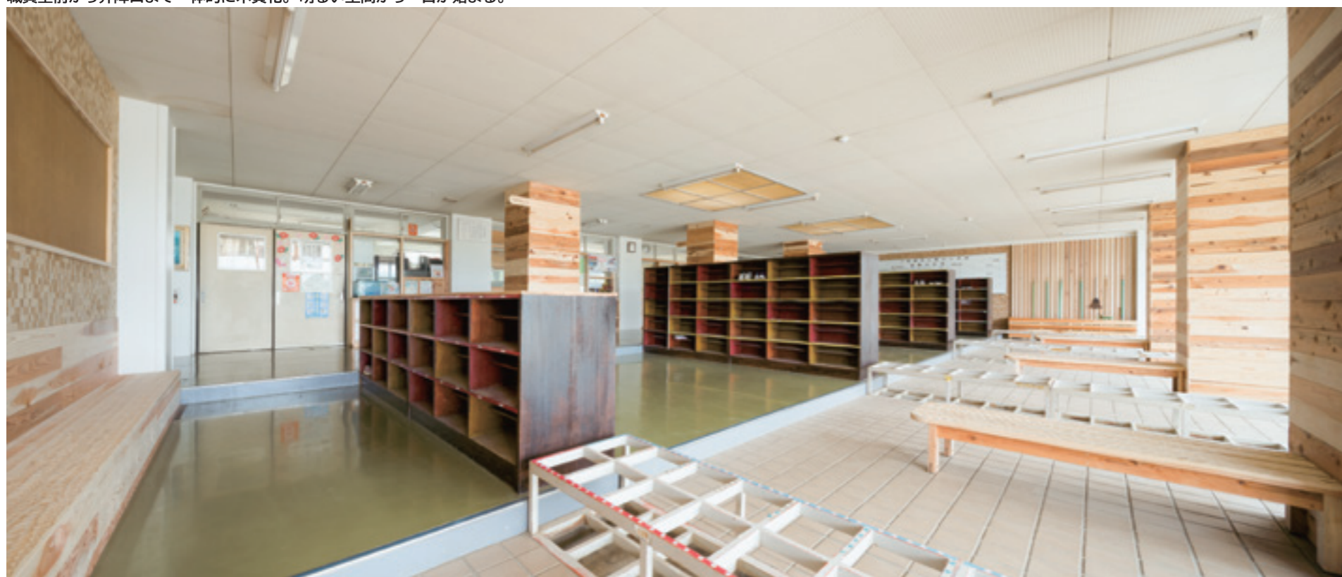
下駄箱の一部は上段をカットして、職員室までの見通しを改善。
