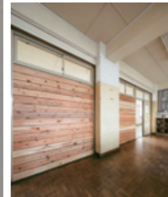
廊下側を下見板張り、教室側を平滑な羽目板張りとし、木材の表情に変化を持たせた。
