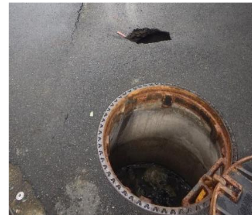
老朽管の破損による道路の陥没
