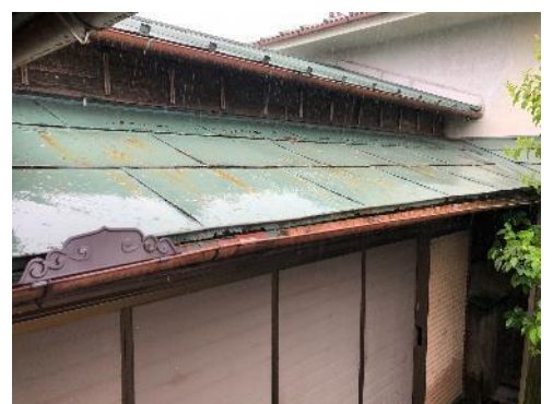
縁側屋根の雨漏りです。屋根には錆が見られる状況です。
