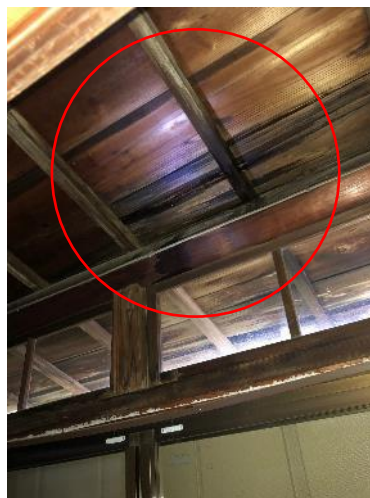
縁側屋根の雨漏りです。屋根には錆が見られる状況です。
