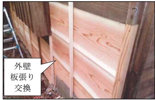
【旧松本剛吉別邸】 主屋の耐震、茶室の構造補強及び劣化箇所等の改修 シロアリによる被害箇所の改修
