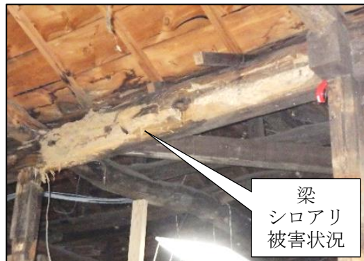
【旧松本剛吉別邸】 主屋の耐震、茶室の構造補強及び劣化箇所等の改修 シロアリによる被害箇所の改修
